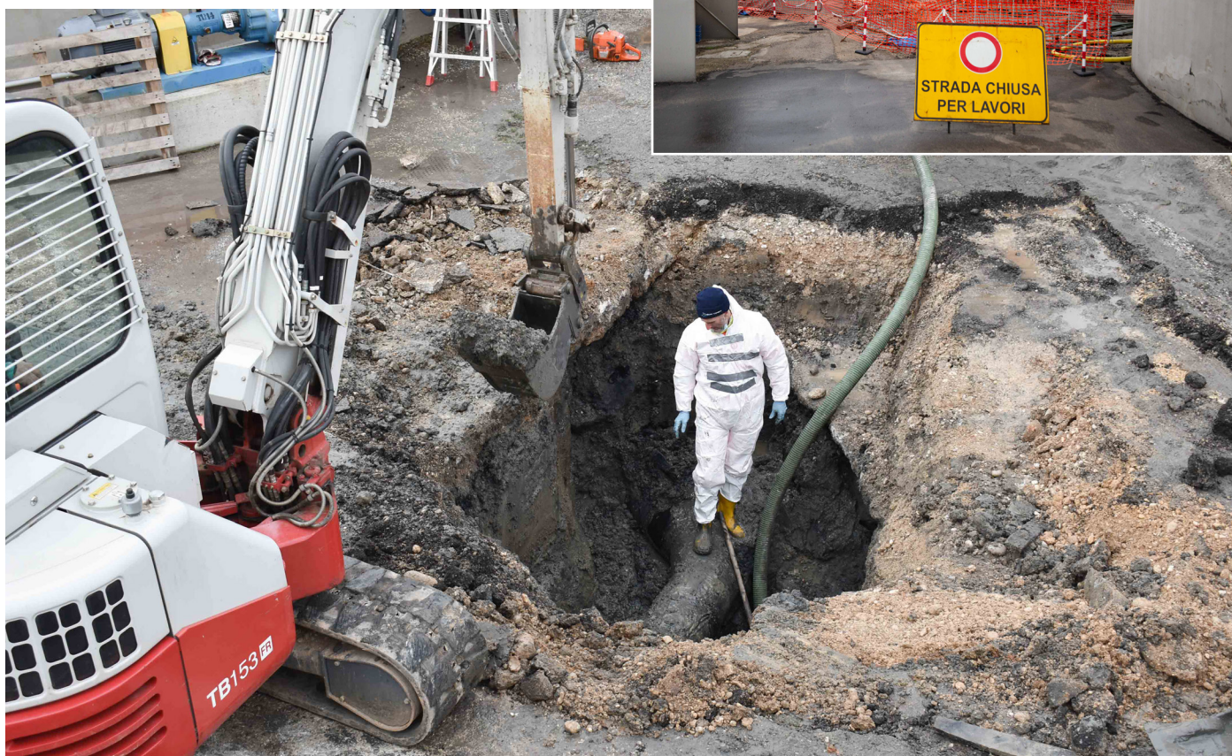
Nelle foto l'intervento di riparazione della tubazione del collettore.
