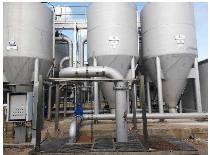
Interconnessione dei nuovi filtri a sabbia con il comparto
