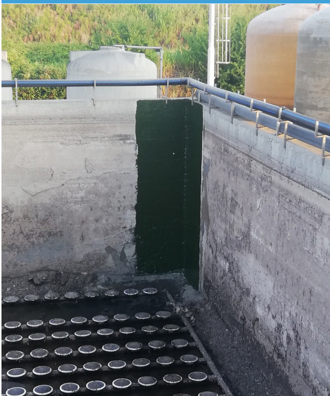
Resinatura interna della vasca del primo stadio
